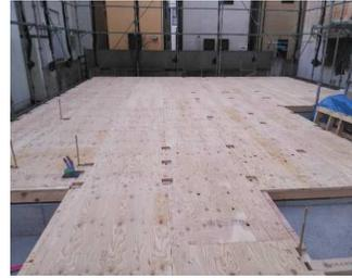
基礎の上には通気タイプの基礎パッキンを載せ、床下の換気をします。土台の腐食防止、防蟻処理にも役立ちます。基礎パッキンの上に土台、910mmピッチのグリッドで大引を組んで床下地材を張り、床の水平構面の強度を高めます。
